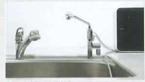
After(立上工事例)
